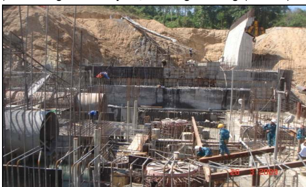
hình 2: Công trình Krông H'Năng, 03/2009
